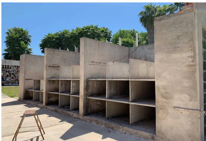
En esta lado, sobre las losetas se continuará muro simple, las dos primeras hiladas se armarán en dos hiladas con 2 hierros de 8 mm, para formar el dintel. En el otro lado falta terminar, según foto adjunta.
