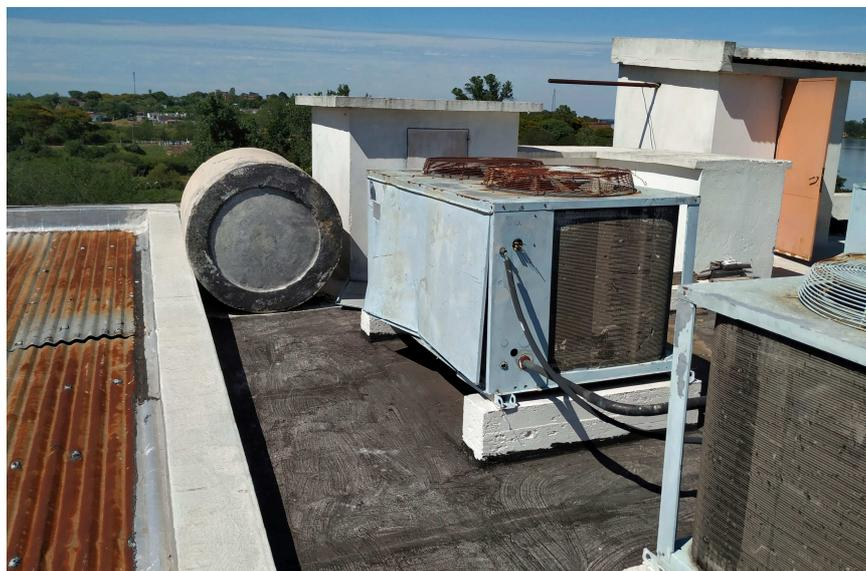
b- Se deberán retirar todas las chapas del techo, sustituir los viejos clavadores de madera por clavadores de tubulares de hierro 50x50, sustituir los viejos canalones de chapa por unos nuevos y colocar nuevas chapas acanaladas calibre 24 en todo el techo liviano.
