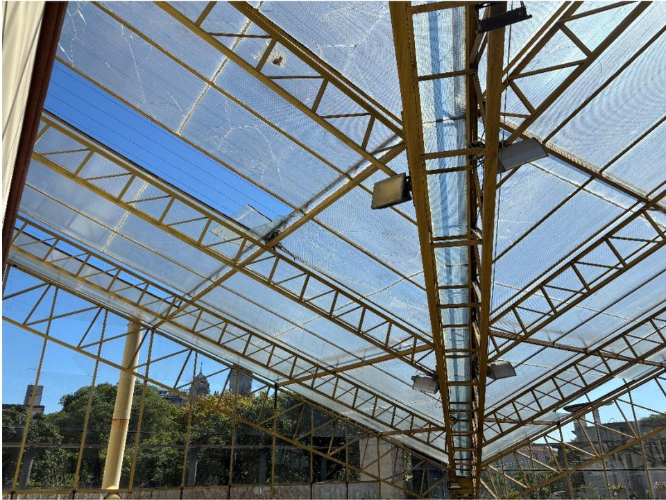
**Toda la estructura metálica deberá ser restaurada, se deberán eliminar los sectores de oxido y pintar, la pintura podrá ser de tipo 3 en 1 op fondo mas esmalte y el color deberá ser el mismo que el existente, de ser necesario se deberá sustituir cualquier elemento en mal estado o que represente un problema de estructura o para el sellado.**
